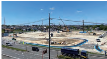
現場状況 (令和6年5月現在)
